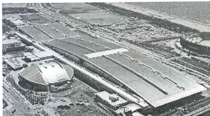
FIG|05 Per il Japan Convention Center, in riva al mare, per la copertura è stato impiegato acciaio inossidabile ferritico contenente molibdeno.
